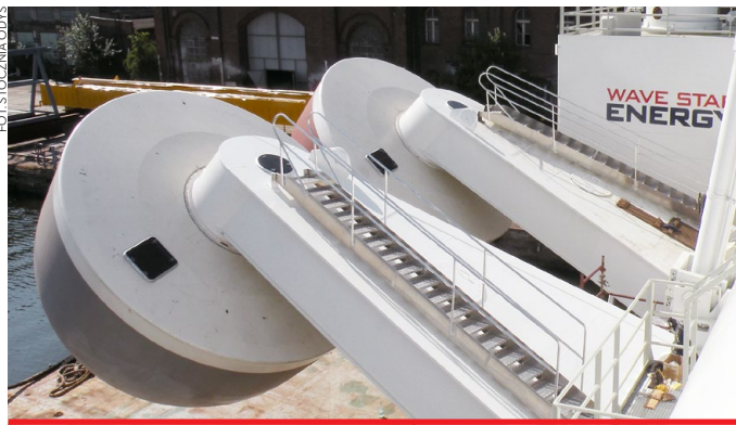
Siłownia Wave Star Energy – ramiona z pływakami
